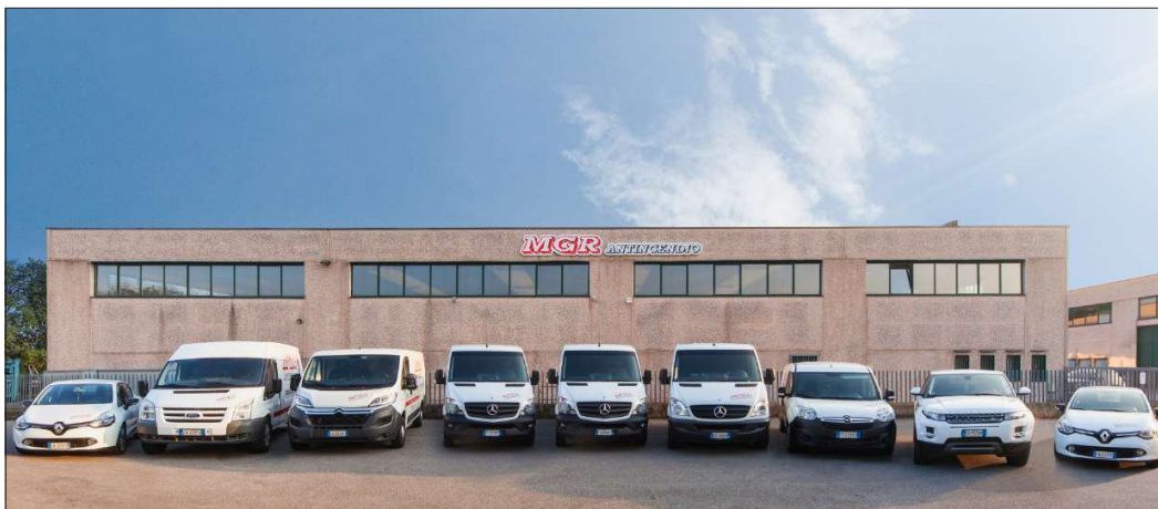
La sede e i mezzi di MGR Antincendio. Sulla destra, in alto Pierangelo Vavassori (presidente POG) con Giorgio Mazzarolo (titolare di MGR); in basso la sponsorizzazione di Colombi Racing Team
