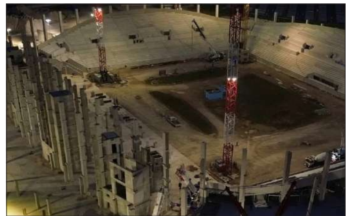
LAVORI IN CORSO - Per il nuovo stadio di Venezia (foto Berro & Sartori Ingegneria), che sorgerà nell'area di Tessera
